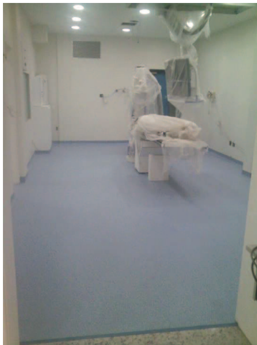
Fig.157 – Piso vinílico em manta assentado na sala de exames após impermeabilização do contrapiso. Detalhe da junta de separação da manta vinílica com a soleira em granito impermeabilizado. Fonte: Autora, 14 de dezembro de 2017.
