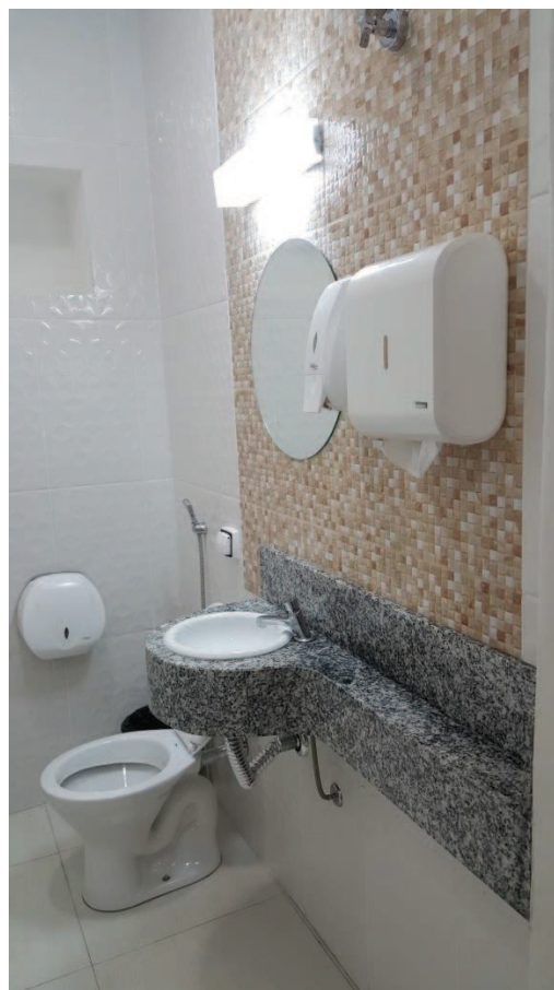
Fig.177 – Bancada dos Lavabos na Recepção (granito impermeabilizado). Bancada do banheiro dos pacientes na área restrita. (granito impermeabilizado) (Finalizando obra). Fonte: Autora, 16 de janeiro de 2018.
