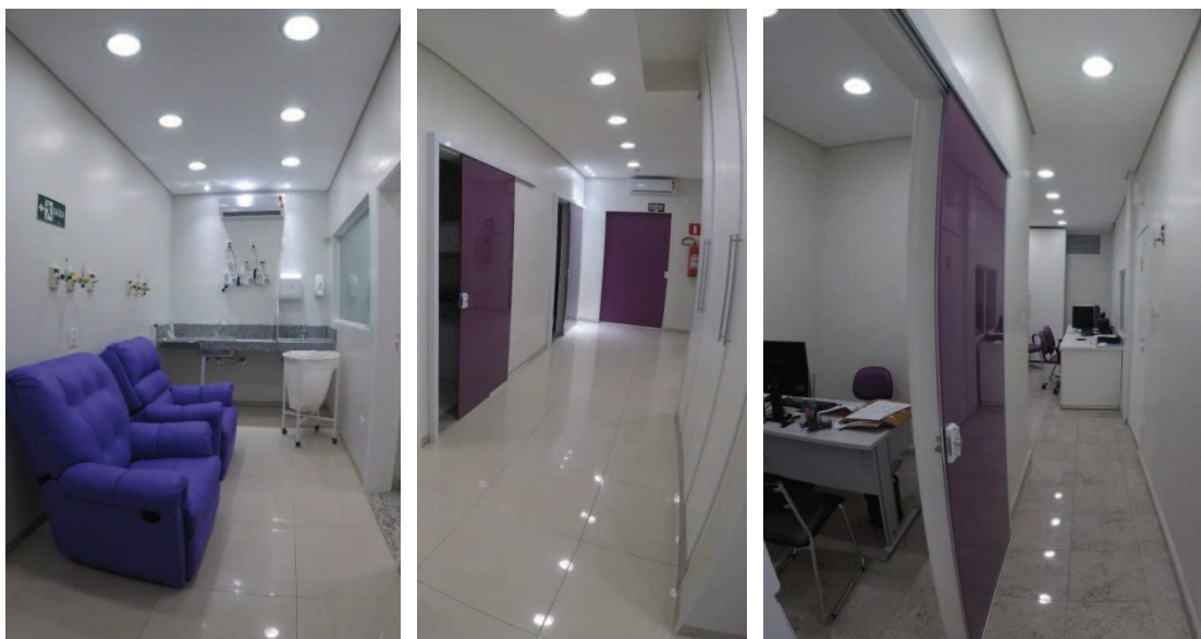
Fig.171 – Iluminação embutida em forro de gesso acartonado com dilatação de 2cm, pintado com tinta acrílica semi-brilho branca. Fonte: Autora, 12 de abril de 2018.
