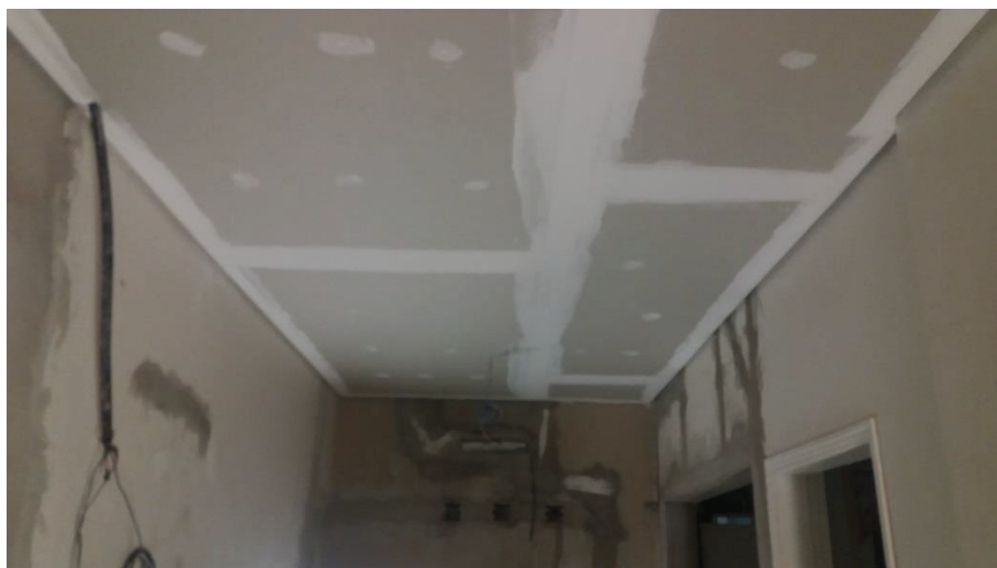
Fig.170 – Forro de gesso acartonado com dilatação lateral de 2cm. Fonte: Autora, 27 de abril de 2017.
