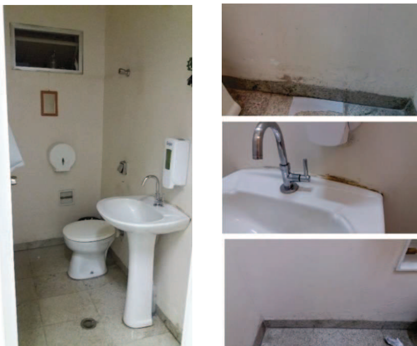
Fig.120 – Ponto de coleta 9: Banheiro Privativo de funcionários e Médicos Fonte: Autora, 2016.
