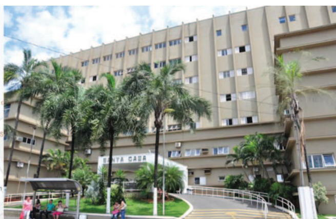
Fig.59 – Fachada Santa Casa de Misericórdia de Barretos Fonte: www.odiarioonline.com.br, 2020.
