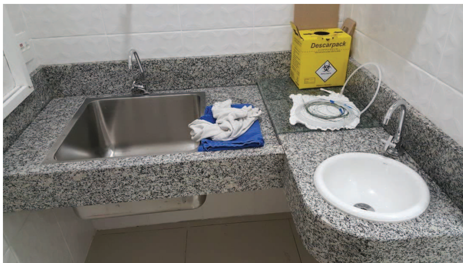
Fig.176 – Bancada do Expurgo (granito impermeabilizado). Cuba em inox profunda para pré-lavagem de materiais. Pia ao lado para lavagem de mãos. (Finalizando obra). Fonte: Autora, 16 de janeiro de 2018.
