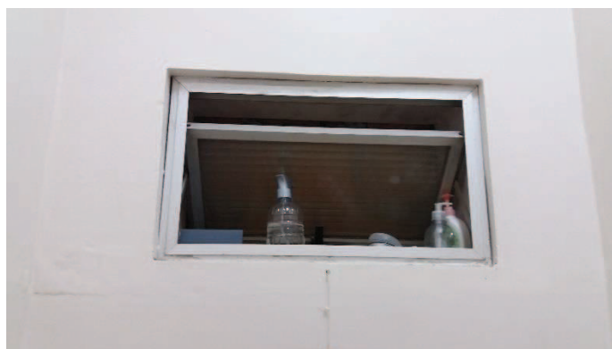
Fig.63 – Banheiro Masculino em 28 de setembro de 2016 e detalhe da janela do banheiro sem acesso a ventilação. Vedada com alvenaria. Fonte: Autora, 2016.
