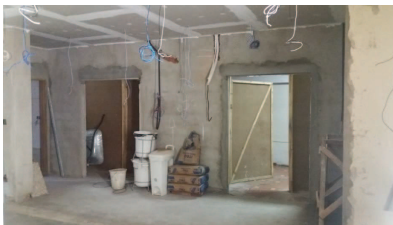
Fig.154 – Piso de granito e contrapiso foram retirados. Contrapiso refeito com impermeabilizante a espera de piso de porcelanato assentado com junta seca e rejunte epóxi. (Recepção)
