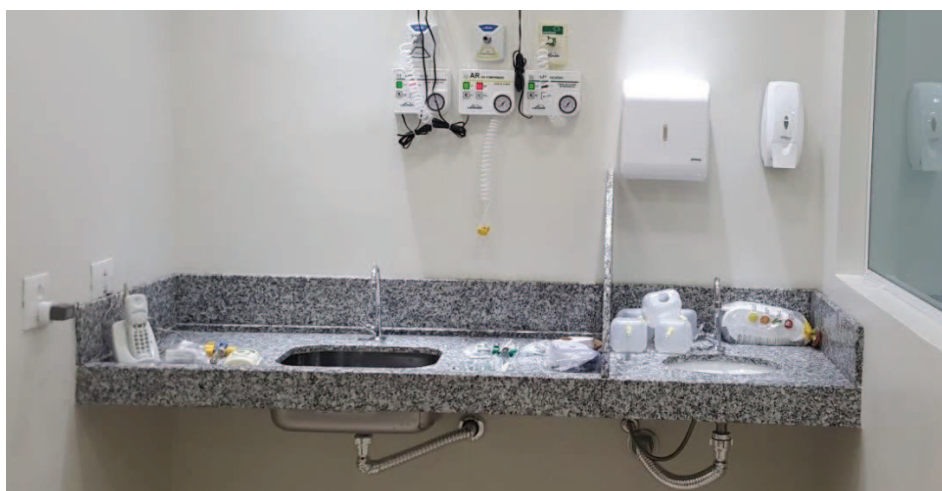
Fig.175 – Bancada do Posto de Enfermagem do Pré-operatório (granito impermeabilizado). Anteparo em granito impermeabilizado dividindo lavagem de mãos e preparo de medicamentos. (Finalizando obra)
