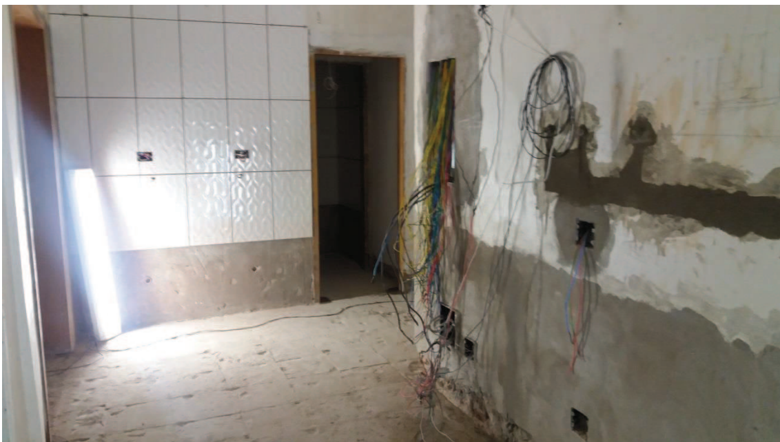
Fig.164 – Imagem fotográfica demonstrando a retirada e novo reboco com impermeabilizante há 1m do piso para prevenir a infiltração ascendente. Notam-se também cortes na parede para passagem de novos dutos e enfiadoes. Na parede à direita, a caixa de passagem. Ao fundo, a parede já com a cerâmica assentada para a instalação do lavabo cirúrgico.
