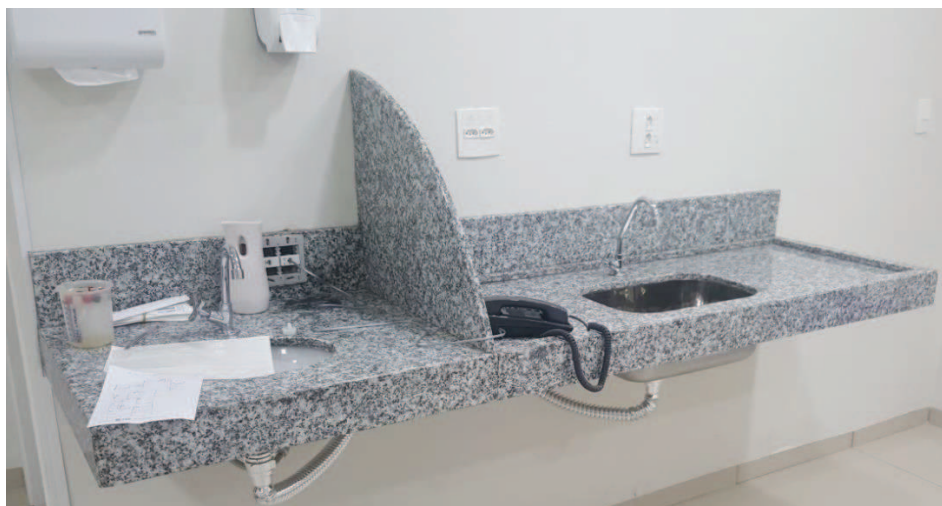
Fig.174 – Bancada do Posto de Enfermagem do Pós-operatório (granito impermeabilizado). Anteparo em granito impermeabilizado dividindo lavagem de mãos e preparo de medicamentos. (Finalizando obra)
