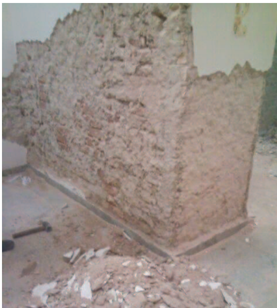
Fig.161 – Retirada de todo o reboco da parede mostrada. Fonte: Autora, 20 de dezembro 2016.
