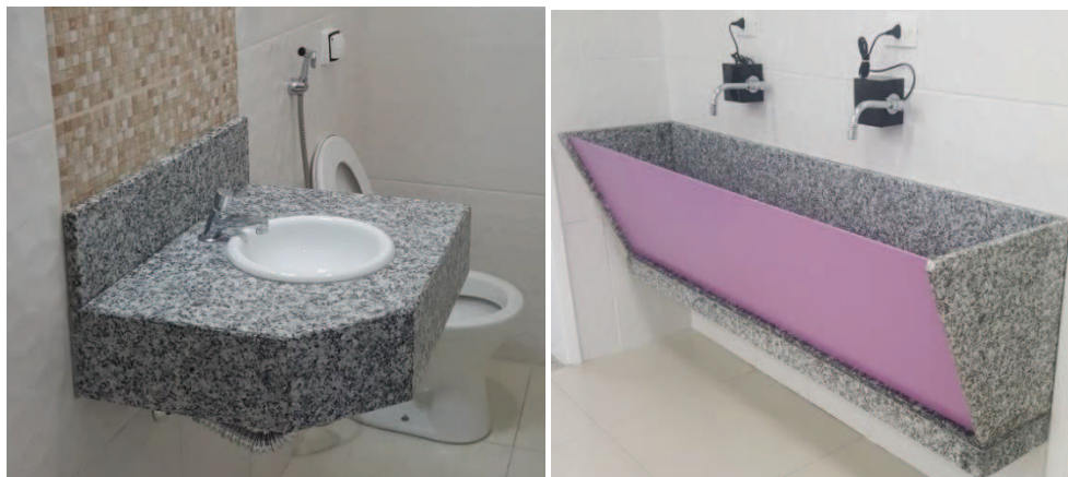
Fig.173 – Bancada do banheiro feminino da recepção (granito impermeabilizado) e Lavabo cirúrgico (granito impermeabilizado, vidro, silicone, cerâmica rejuntada com epóxi). Torneiras automatizadas.
