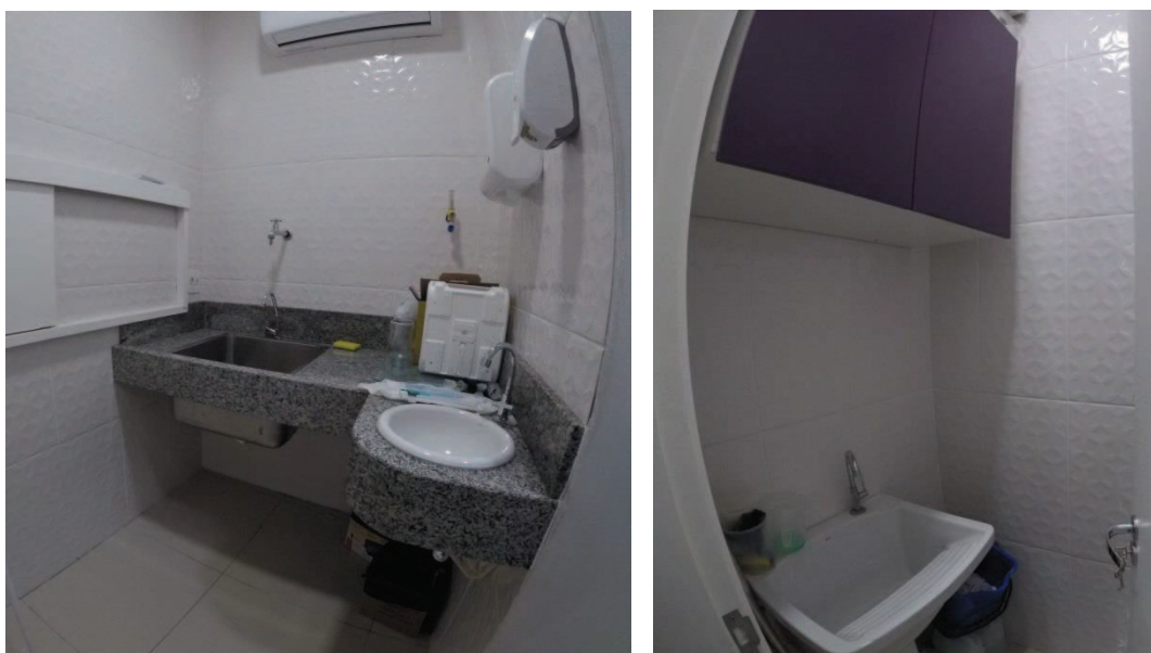
Fig.181 – Expurgo e DML revestidos com cerâmica com relevo liso. Rejunte epóxi.
