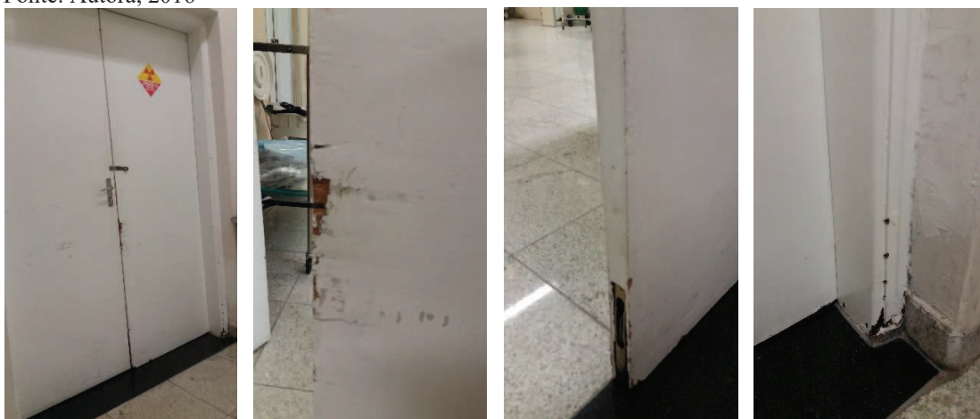
Fig.113 – Detalhes da porta do ponto de coleta 7 (Sala de Exame) Fonte: Autora, 2016
