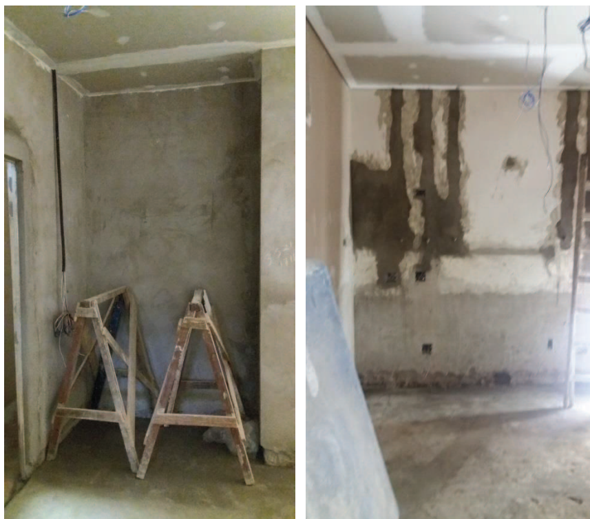
Fig.162 – Na primeira foto pode-se notar que foi retirado e refeito todo o reboco da parede com impermeabilizante, pois encontrava-se toda comprometida. Já na segunda foto, foi retirado e refeito o reboco com impermeabilizante apenas onde encontravam-se as infiltrações ascendentes. Notam-se também na segunda foto, cortes na parede para passagem de novos dutos e enfições. Fonte: Autora, 27 de abril de 2017.
