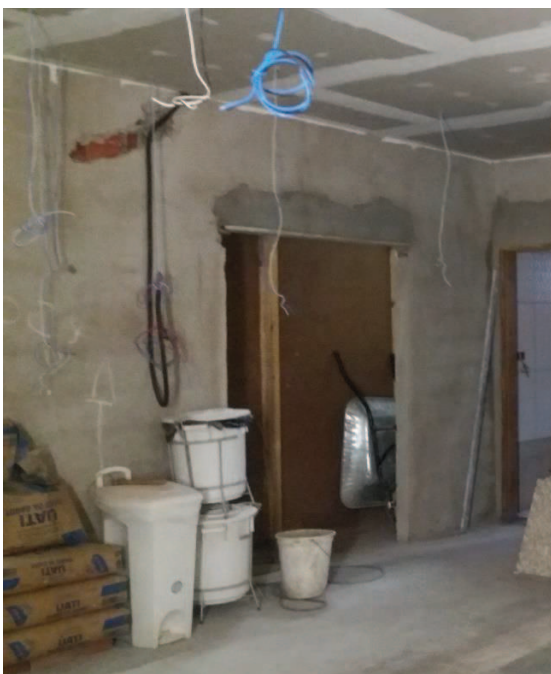
Fig.195 – Ponto de coleta 3: Porta Acesso Restrito Hemodinâmica Fonte: Autora, 2017.
