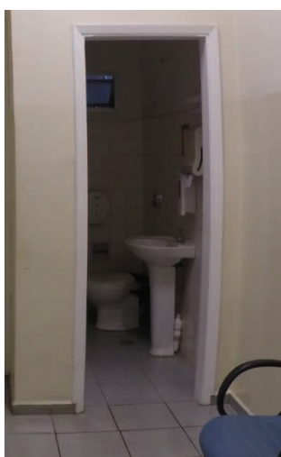
Fig.63 – Banheiro Masculino em 28 de setembro de 2016 e detalhe da janela do banheiro sem acesso a ventilação. Vedada com alvenaria. Fonte: Autora, 2016.
