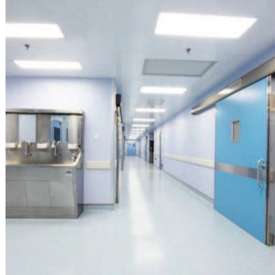
Fig.41: Centro Cirúrgico na cidade de Jandua pintado com tinta tipo epóxi. Fonte: https://www.fkvestimentos.com.br/pinturas-industriais/pinturas-em-epoxi/
