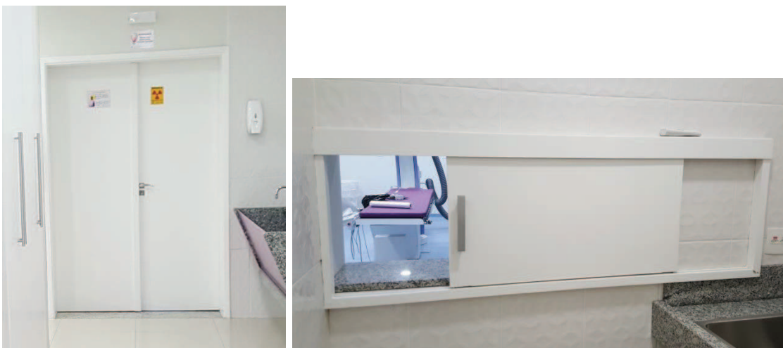
Fig.183 – Portas da Sala de Exame e Janela da Sala de Exames para o Expurgo Fonte: Autora, 16 de janeiro de 2018
