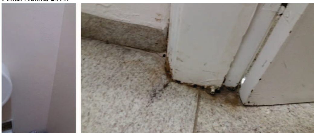
Fig.121 – Ponto de coleta 9: Banheiro Privativo de funcionários e Médicos Fonte: Autora, 2016.
