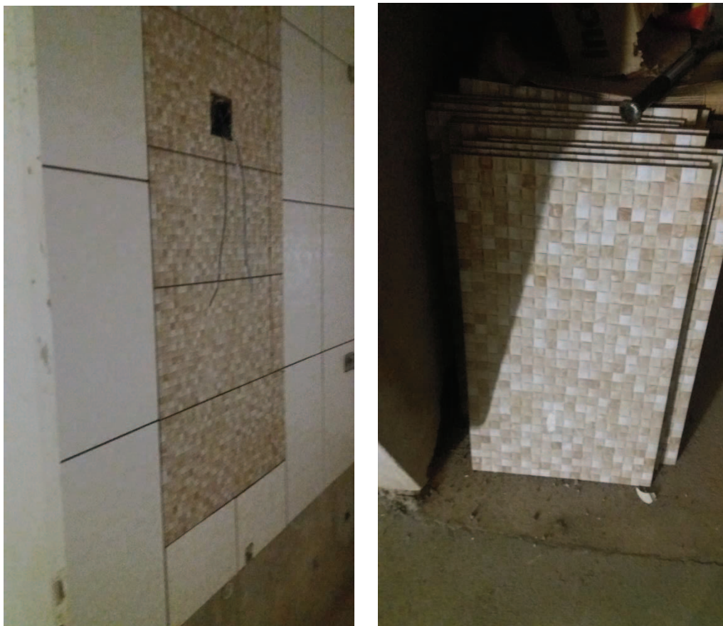
Fig.180 – Na primeira foto pode-se notar o revestimento instalado na parede antes do rejuntamento. Na segunda foto vê-se a peça do revestimento estampado pastilhado para efeito estético.
