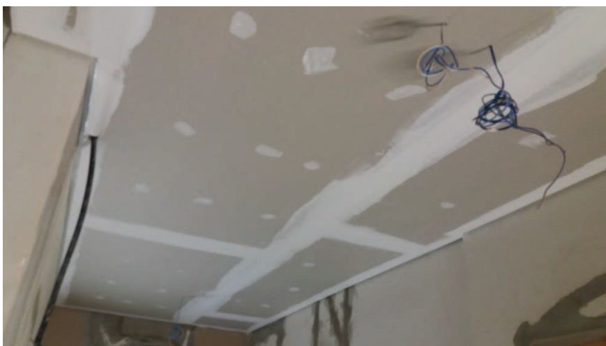
Fig.169 – Forro de gesso acartonado com dilatação lateral de 2cm. Fonte: Autora, 27 de abril de 2017.
