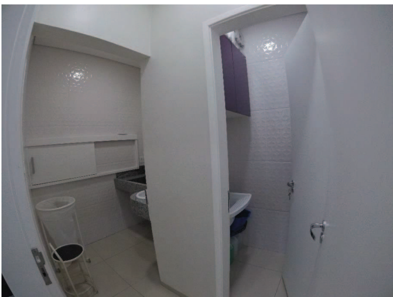
Fig.238 – Hall entre o expurgo e o DML. Expurgo a esquerda. DML a direita. Fonte: Autora, 2018.
